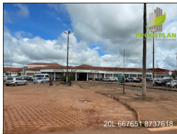
Foto 4.22: Hospital Regional em Cacoal.
