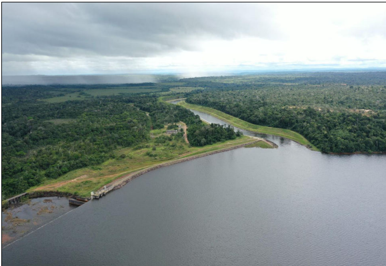
Foto 4.111: Vista aérea do reservatório da UHE Rondon II.
