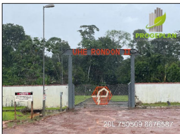
Foto 4.104: Portão de acesso a UHE Rondon II.
