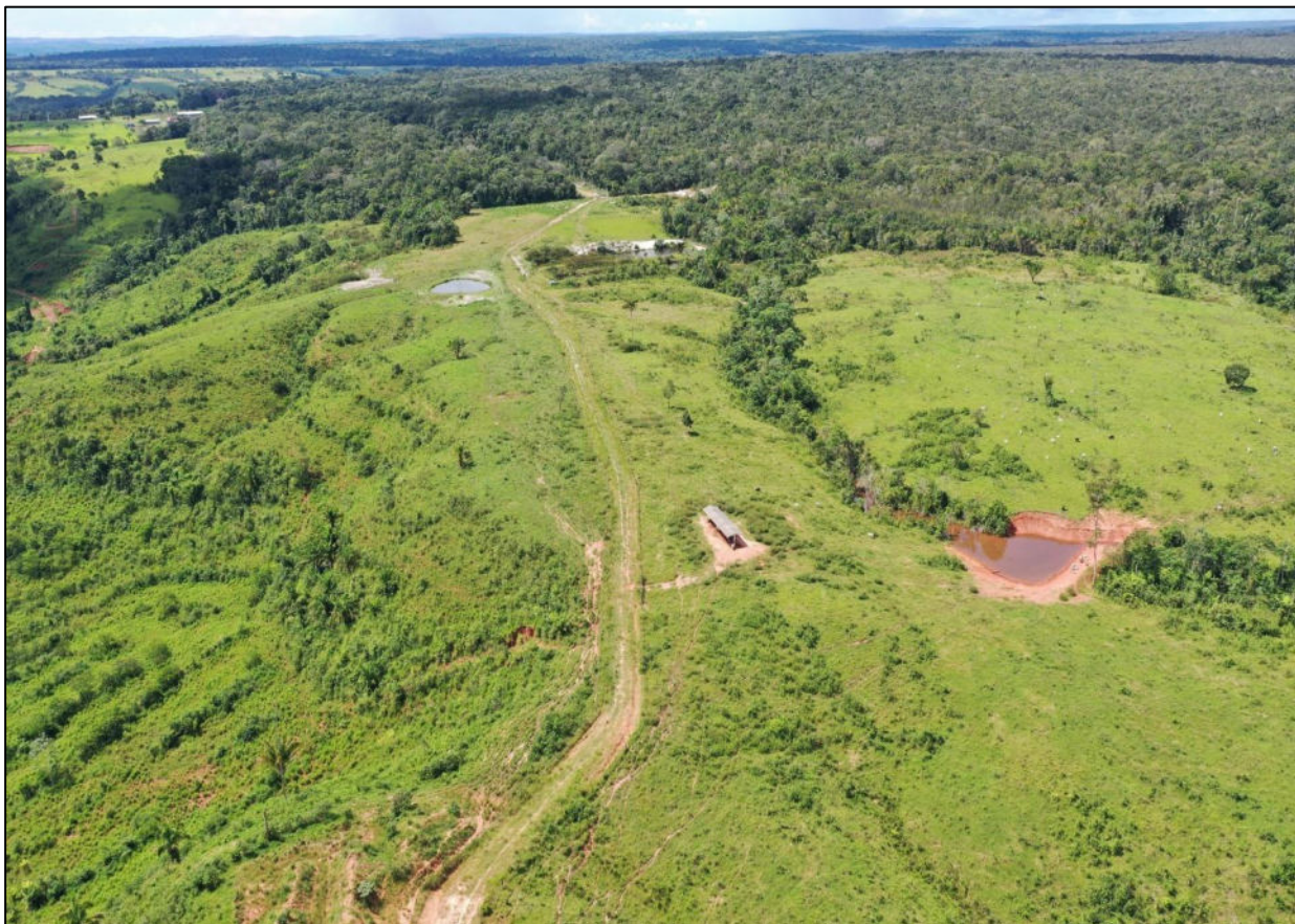
Foto 4.89: Vista aérea da propriedade P-1 (tanques, remanescentes de curvas de nível, estrutura de galpão e via).
