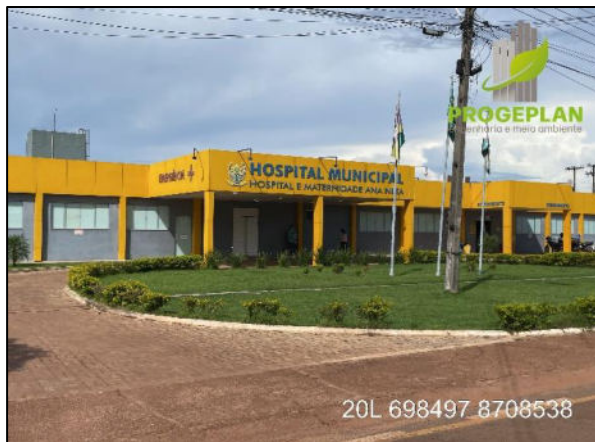
Foto 4.69: Hospital Municipal e Maternidade em Pimenta Bueno.
