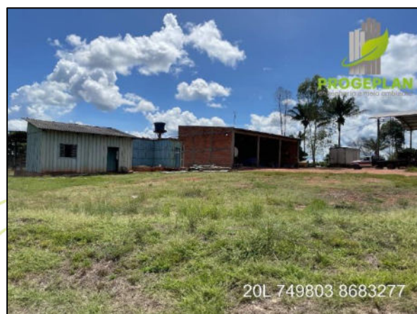
Foto 4.87: Estruturas da propriedade P-1.
