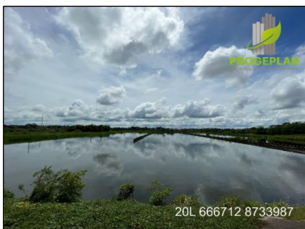
Foto 4.2: Estação de tratamento de esgoto de Cacoal.
