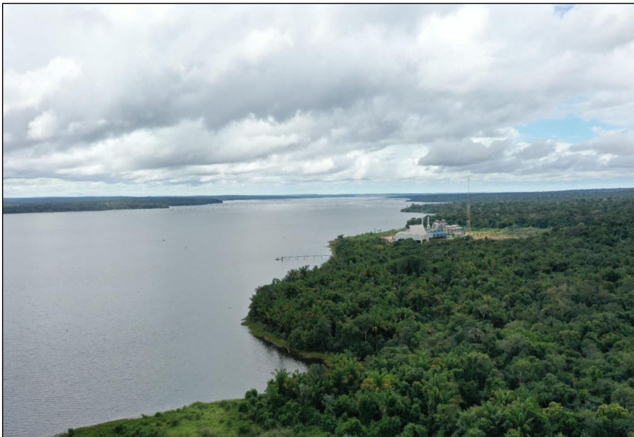
Foto 4.110: Vista aérea do reservatório da UHE Rondon II e infraestrutura da UTE Rondon II.
