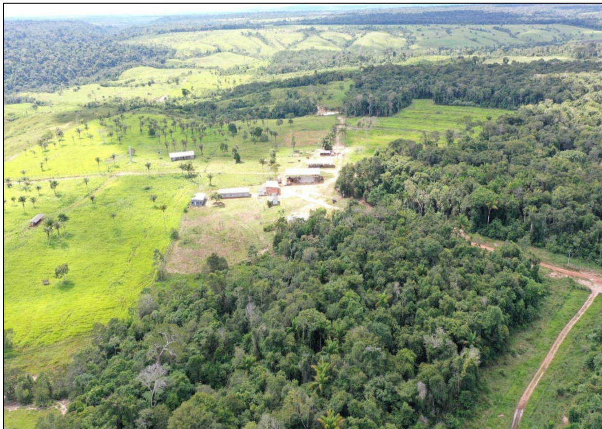
Foto 4.91: Vista aérea da propriedade P-1 (estruturas de galpão e outras construções).
