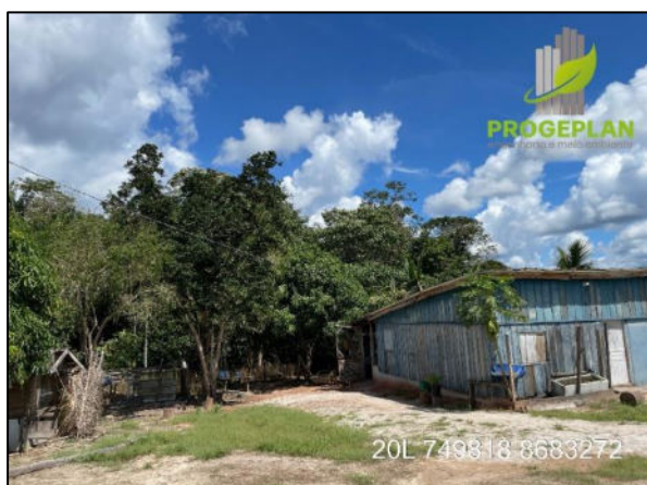
Foto 4.86: Estruturas da propriedade P-1.
