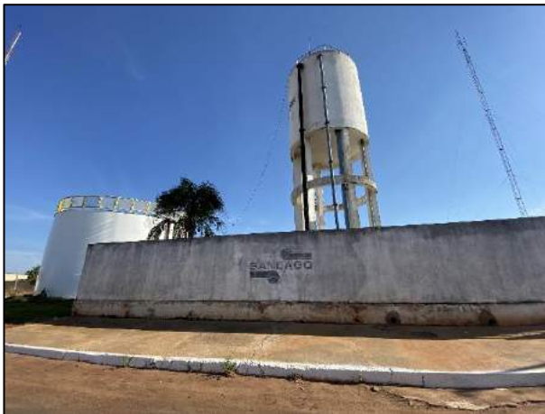
Foto 1.49: Instalações da Saneago em Caçu.
