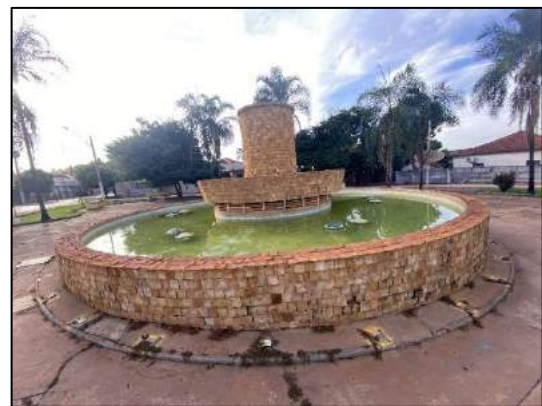
Foto 1.27: Registro das condições da fonte/chafariz em meio a praça pública.
