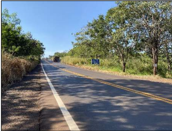
Foto 1.51: Via de acesso ao município (GO 206) de Caçu.
