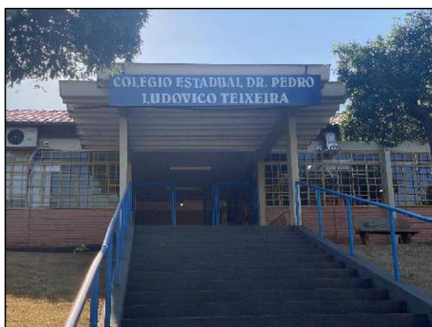
Foto 1.69: Registro de infraestrutura de Colégio Estadual em Itarumã.
