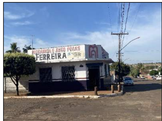
Foto 1.7: Exemplo das condições do asfalto nas vias internas da sede municipal.
