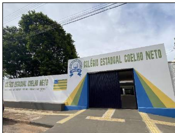
Foto 1.68: Registro de infraestrutura de Colégio Estadual em Itarumã.
