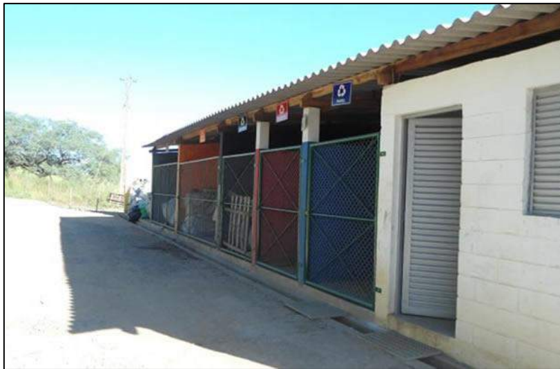
Figura 10.11: Baias de acondicionamento temporário de resíduos, com identificação de acordo com as normas da Resolução CONAMA nº 275/2001 (Foto ilustrativa).
