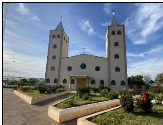
Foto 1.46: Igreja na área central da cidade
