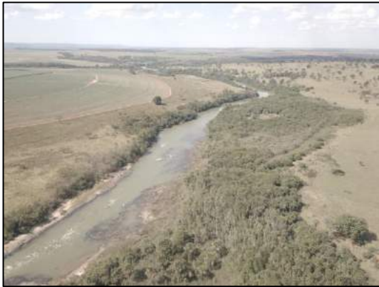
Foto 1.92: Vista aérea do local onde será o reservatório da PCH Guariroba.
