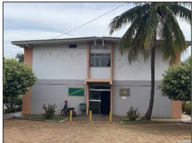
Foto 1.72: Instalações da Prefeitura Municipal de Itarumã e Junta do Serviço Militar.
