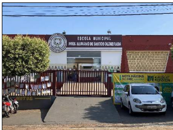
Foto 1.67: Registro de infraestrutura de Escola Municipal em Caçu.
