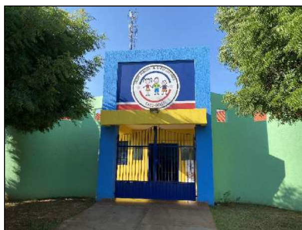
Foto 1.70: Registro de infraestrutura de creche municipal em Itarumã.
