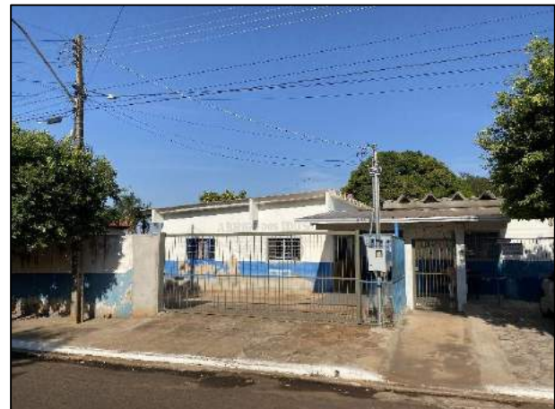
Foto 1.76: Registro das instalações do Abrigo de idosos em Caçu.
