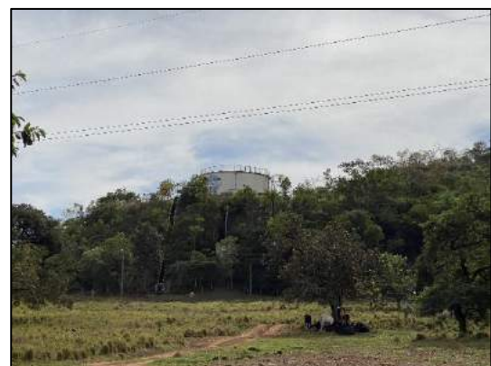
Foto 1.3: Elevatória de Abastecimento de Água
