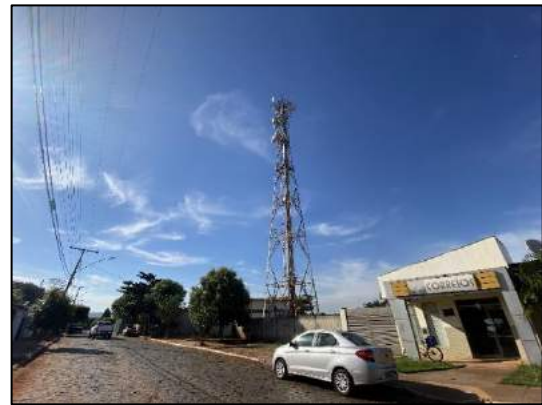
Foto 1.33: Registro de torre de comunicação.
