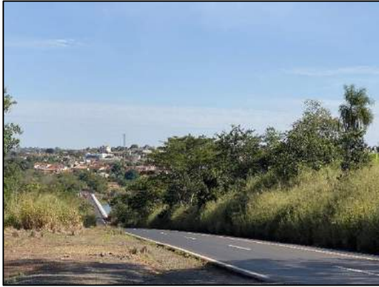
Foto 1.4: Avenida Juscelino Kubitschek, em continuação à GO 174.
