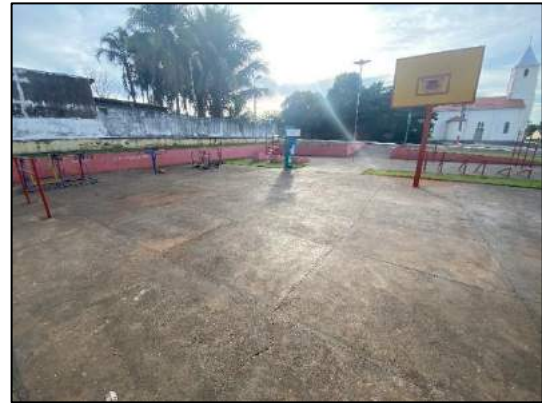
Foto 1.25: Quadra poliesportiva com estrutura lateral de academia pública da saúde e/ou ponto de encontro comunitário (PEC).
