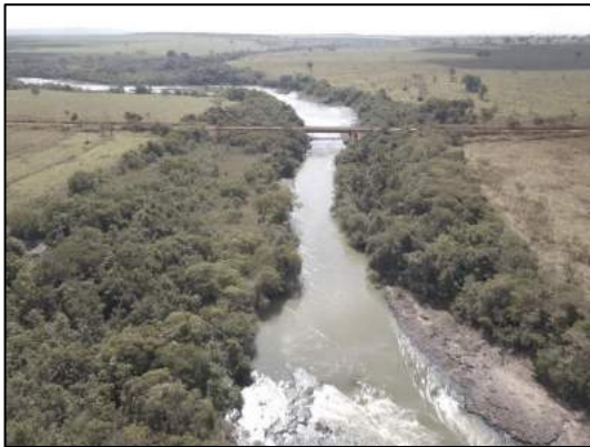
Foto 1.86: Ponte sobre a Rodovia Júlio Simões GO 174. Vista área registrada por Drone.
