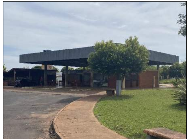
Foto 1.60: Infraestrutura da rodoviária municipal de Itarumã.
