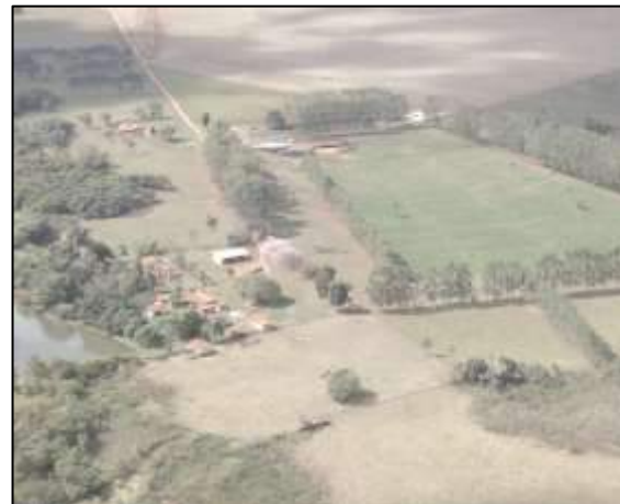
Foto 3.2: Edificações lindeiras ao empreendimento.
