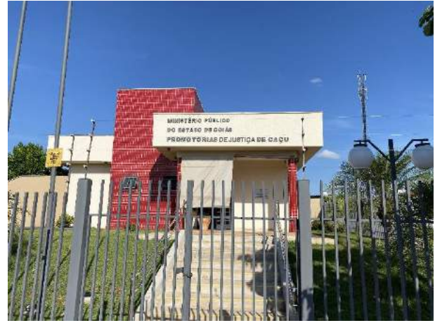
Foto 1.74: Instalações do Ministério Público e Promotoria de Justiça de Caçu.
