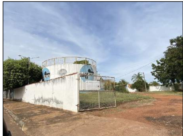
Foto 1.50: Instalações da Saneago em Itarumã.
