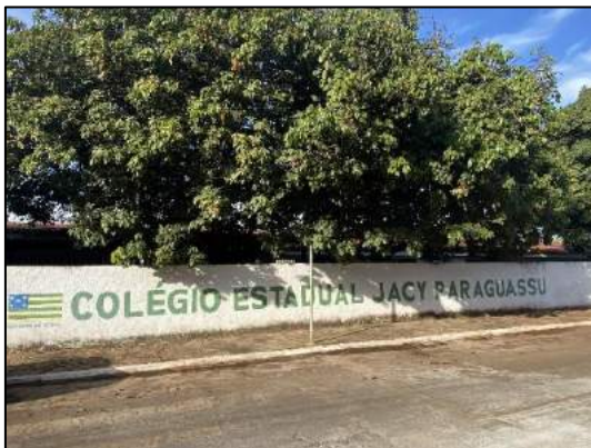
Foto 1.17: Registro de infraestrutura de Colégio Estadual.
