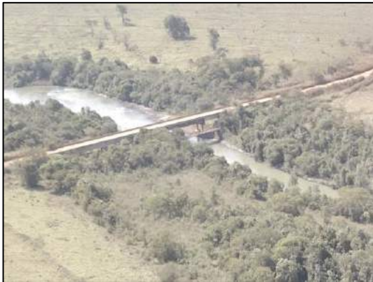
Foto 1.88: Ponte sobre a Rodovia Júlio Simões GO 174. Vista área registrada por Drone.
