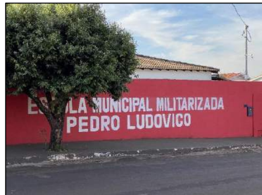
Foto 1.18: Registro de infraestrutura de Colégio Municipal.
