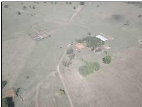
Foto 3.3: Edificações lindeiras ao empreendimento.
