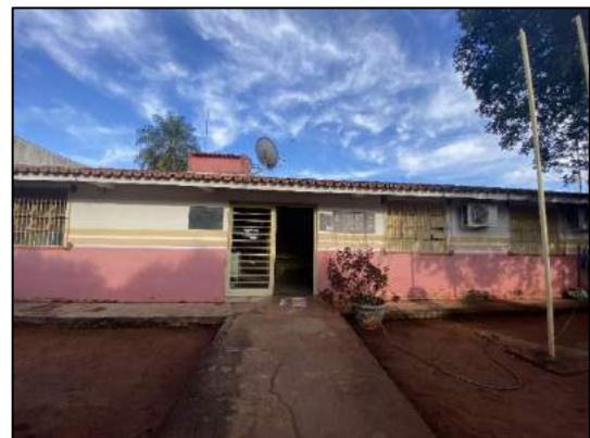
Foto 1.14: Registro da infraestrutura do Unidade Básica "C".
